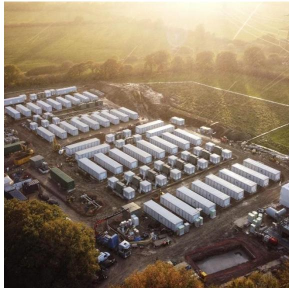
Radi se o divovskom sistemu za baterijsko skladištenje električne energije koji je upravo priključen na britansku elektroenergetsku mrežu. Snaga baterijskog skladišta energije Minety iznosi 100 MW, a kapacitet skladištenja električne energije 100 MWh.
